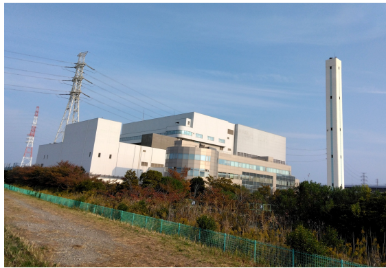
11月5日 江戸川堤から撮影
