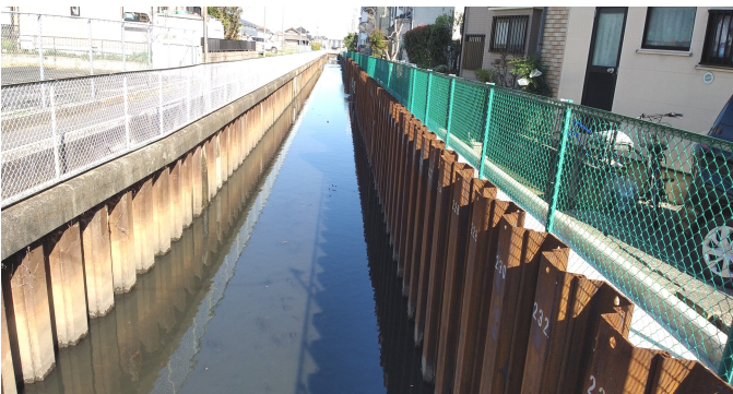
昨年、派川大柏川のコンクリート護岸の鋼護岸への強化工事が実施され、今年は大雨前に、川の中の草刈り・清掃が終了
