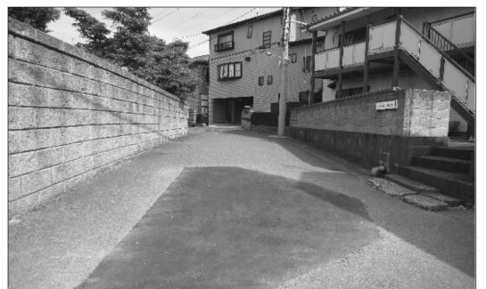
新井1丁目12、補修後の写真
