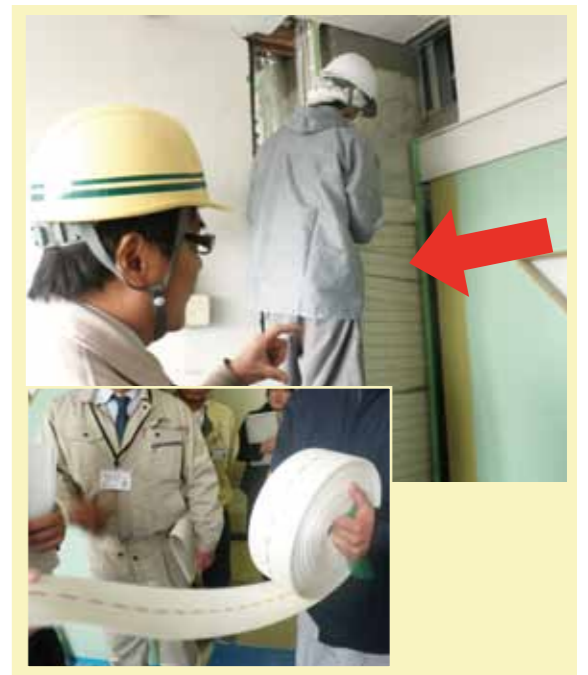
党市議団は、松戸市立東病院の包帯補強工事を視察。柱を包帯のように巻いて倒壊を防ぐ補強で、音も振動もなく、病院の診療も通常通り行われています。
